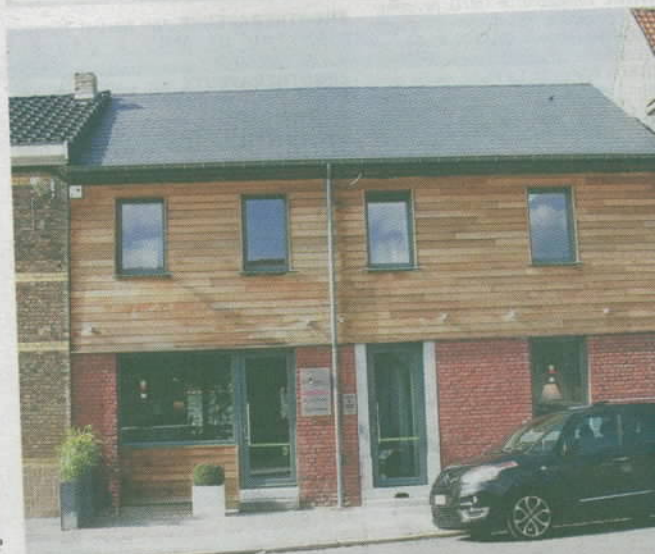
Des bureaux sur trois étages.
